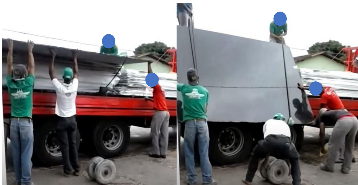
Figura 18 – Funcionários descarregando as chapas do caminhão com carrinho
